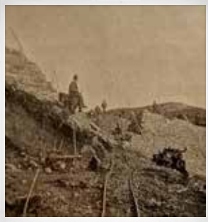
Bau der „Hohen Mauer“
